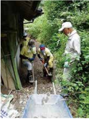
土砂の搬出作業
